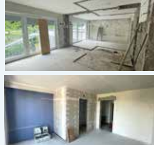
Die betreffenden Zimmer werden entkernt und wieder neu aufgebaut.
