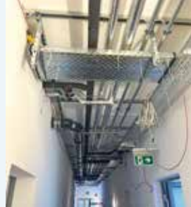
Die kompletten Versorgungsleitungen werden erneuert.
