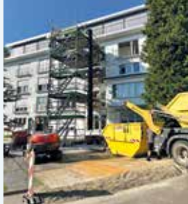
Bauprojekt Ostflügel: Das Gerüsttreppenhaus für den ersten Bauabschnitt steht.
