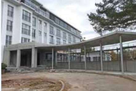
Aktuelle Fotos vom Bau: Der neue Haupteingang
