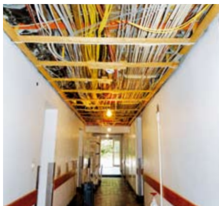
Elektroarbeiten im Untergeschoss
