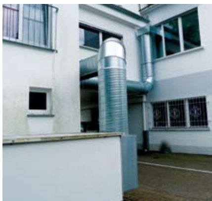
Die Küchenlüftung wurde schon vom Dach des 2. OG abgebaut
