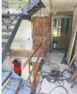
Ostflügel, Baustelle Fluchttreppenhaus
