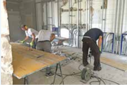
Westflügel Bauphase 2 aktuell: Ein Blick auf die Installationsarbeiten in der Küche
